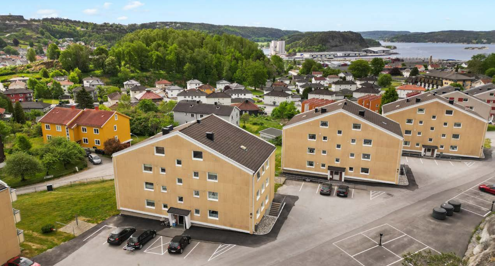
Borettslaget er tilknyttet Halden Boligbyggelag og består av 4 mindre boligblokker med totalt 44 boliger
