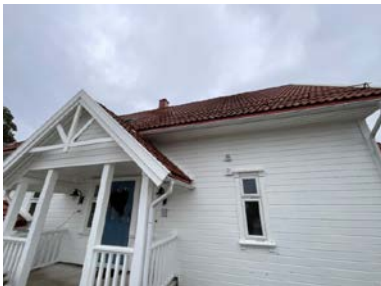
Snøfangere montert ihht byggeårets krav.
