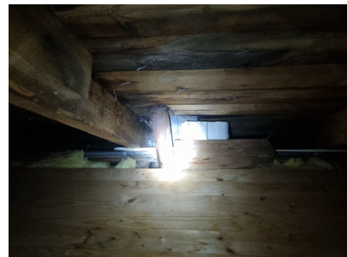
Vann/kondesmerker på loft ved lufterør
