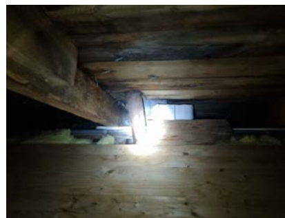
Vann/kondesmerker på loft ved lufterør
