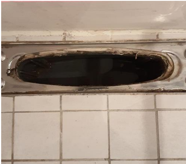
Våtrom - [Bad underetasje]
