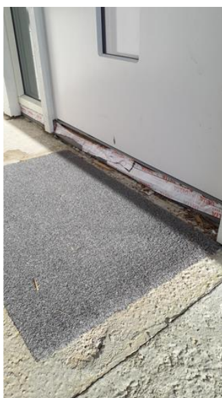
Dører og vinduer - [Ytterdør]
