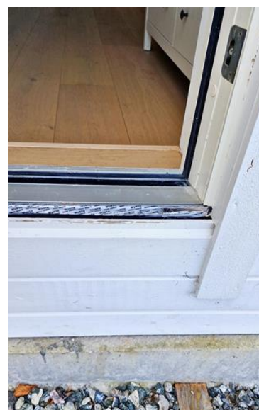
Dører og vinduer - [Balkongdør underetasje]
