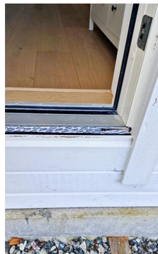
Dører og vinduer - [Balkongdør underetasje]
