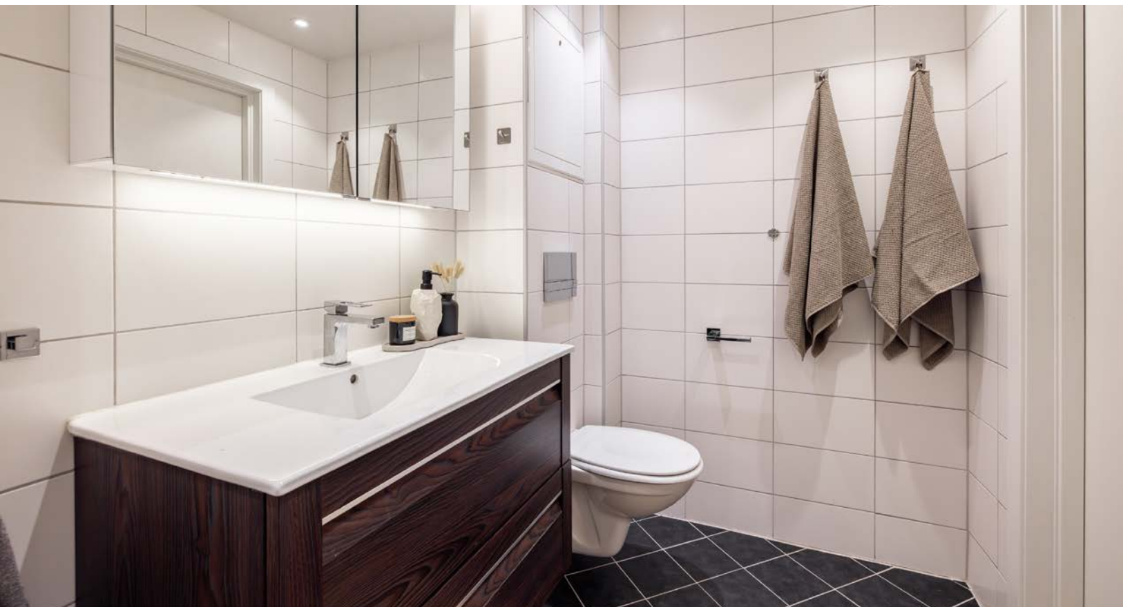
Rommet er innredet med dusjhjørne, vegghengt toalett, speilskap og servantskap med ovenpåliggende servant.
