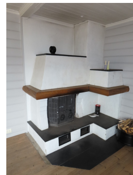
Peis med støpejernsinnsats i stue - 1.etg.
