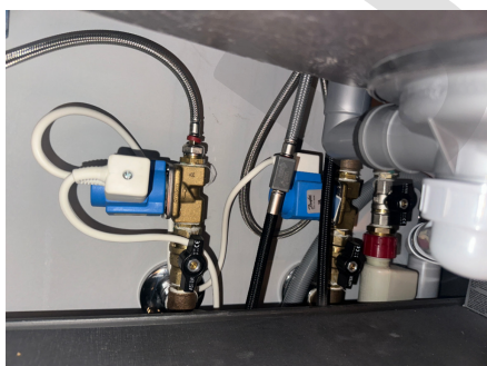
Røropplegg i kjøkkenbenk med Waterguard
