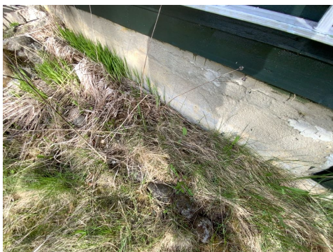
Kontroll av drenering/fuktsikring.
