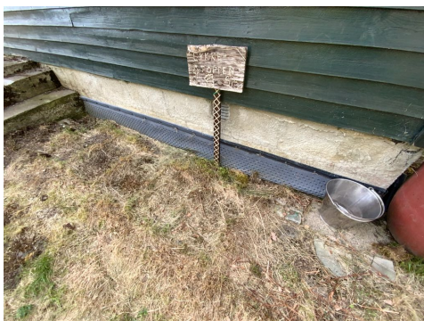
Kontroll av drenering/fuktsikring.
