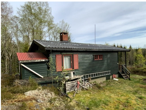
Besiktigelse av taktekke.
