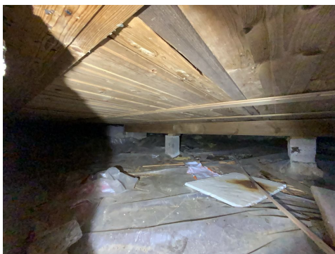
Besiktigelse av kryprom.
