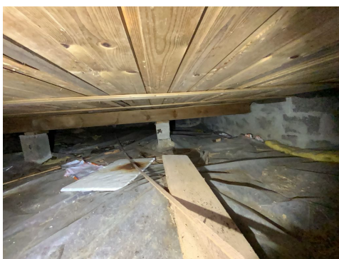
Besiktigelse av kryprom.
