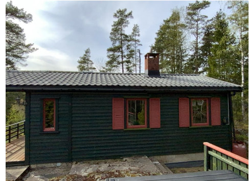
Besiktigelse av taktekke.
