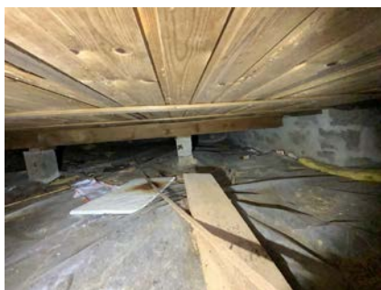
Besiktigelse av krypprom.
