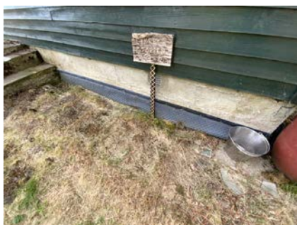
Kontroll av drenering/fuktsikring.
