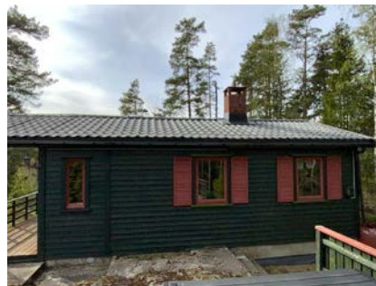
Besiktigelse av taktekke.
