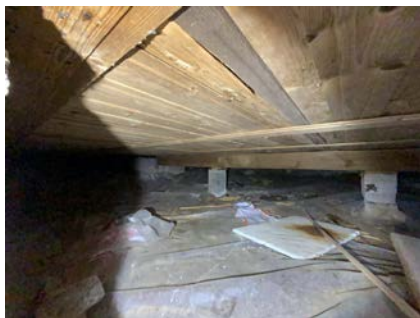
Besiktigelse av krypprom.
