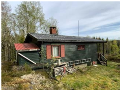
Besiktigelse av taktekke.
