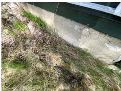
Kontroll av drenering/fuktsikring.
