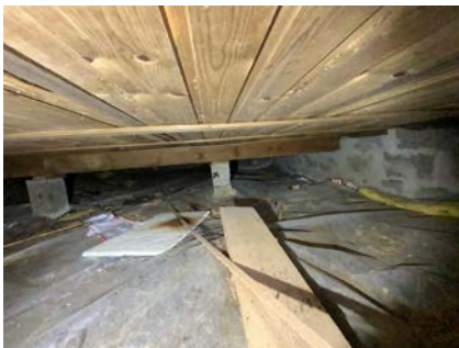
Besiktigelse av kryprom.
