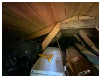
Generell besiktigelse. Noe overfylt loft med begrenset tilkomst.
