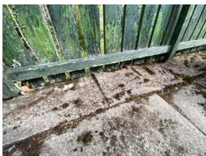
Råteskadet kledning
