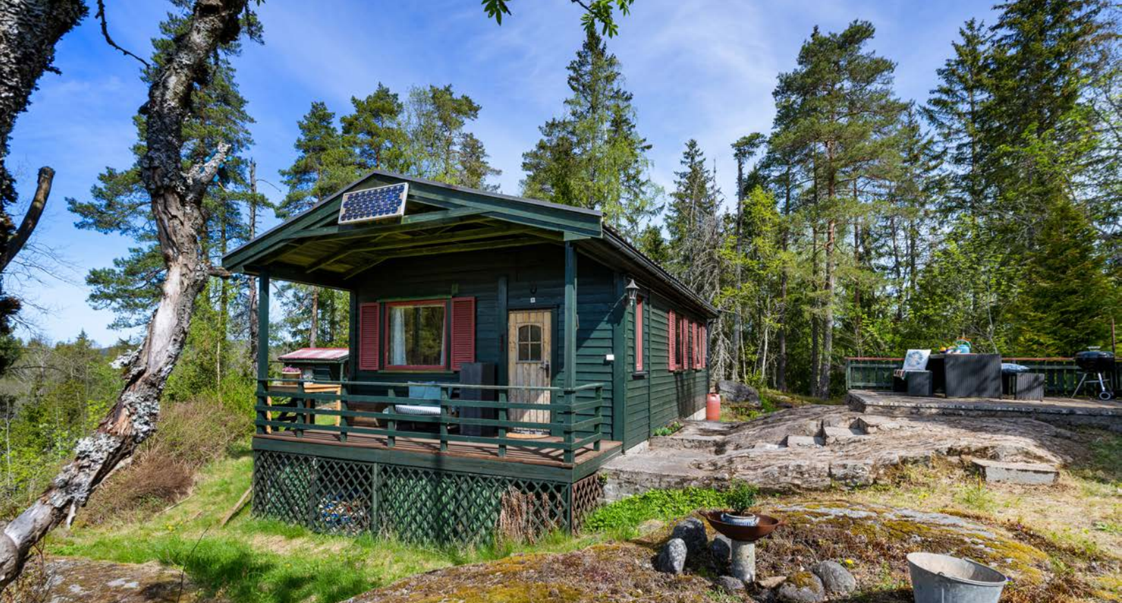
Det er montert solcellepanel.
