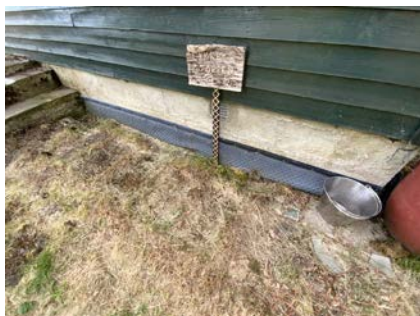
Kontroll av drenering/fuktsikring.
