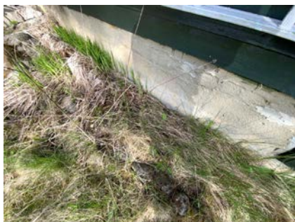
Kontroll av drenering/fuktsikring.
