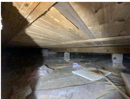
Besiktigelse av kryprom.
