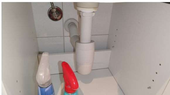
Kontroll av røropplegget.
