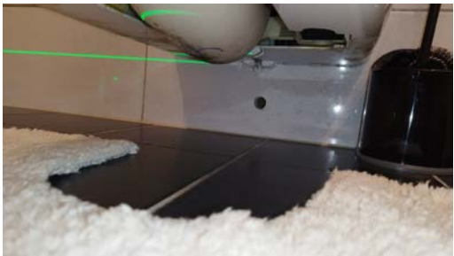
Drensåpning fra innebygget susterne.
