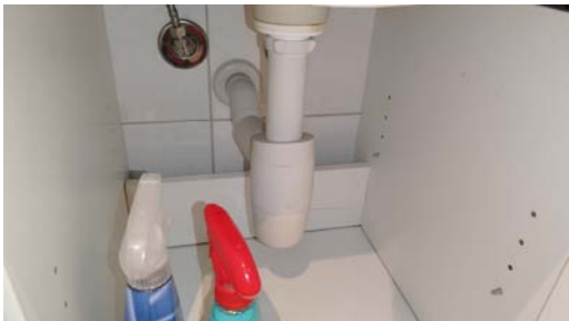
Kontroll av røropplegget.
