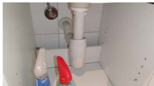
Kontroll av røropplegget.
