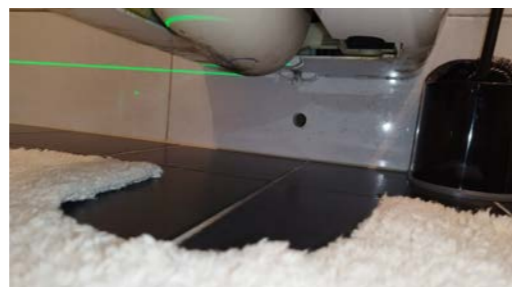
Drensåpning fra innebygget systerne.
