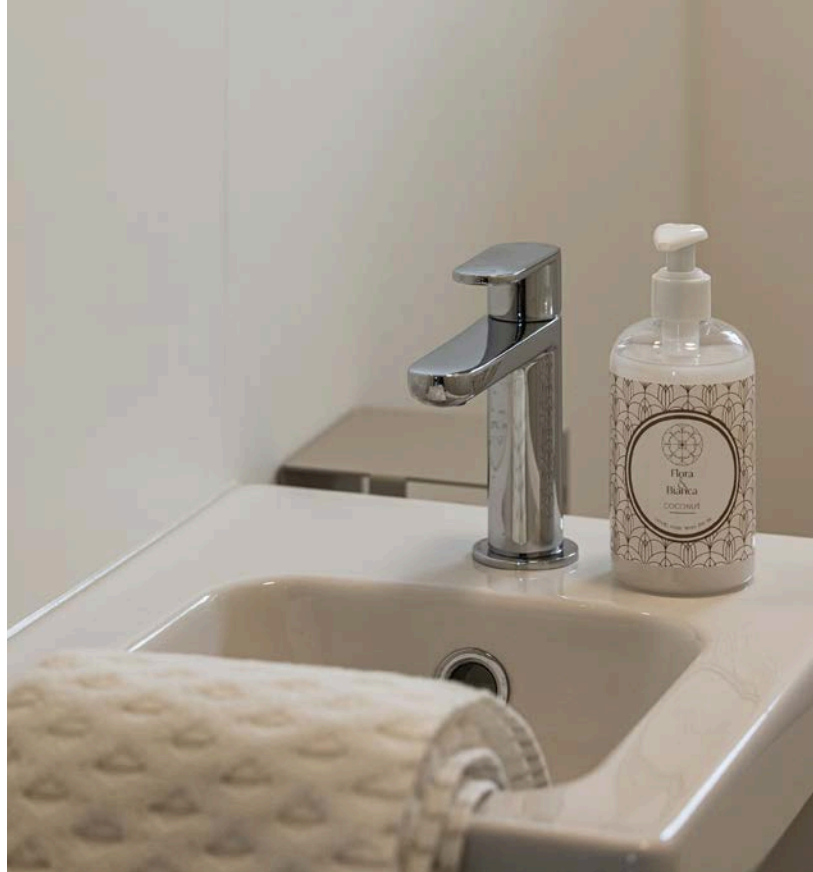
Badet i hoveddel i kjeller har vannbåren gulvvarme.
