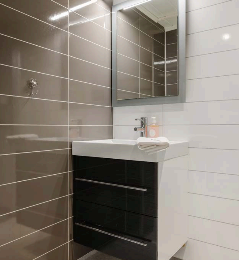
På gulvet er det belegg, mens veggene har baderomsplater. Servantskap med heldekkende servant. Speil med lys i overkant.
