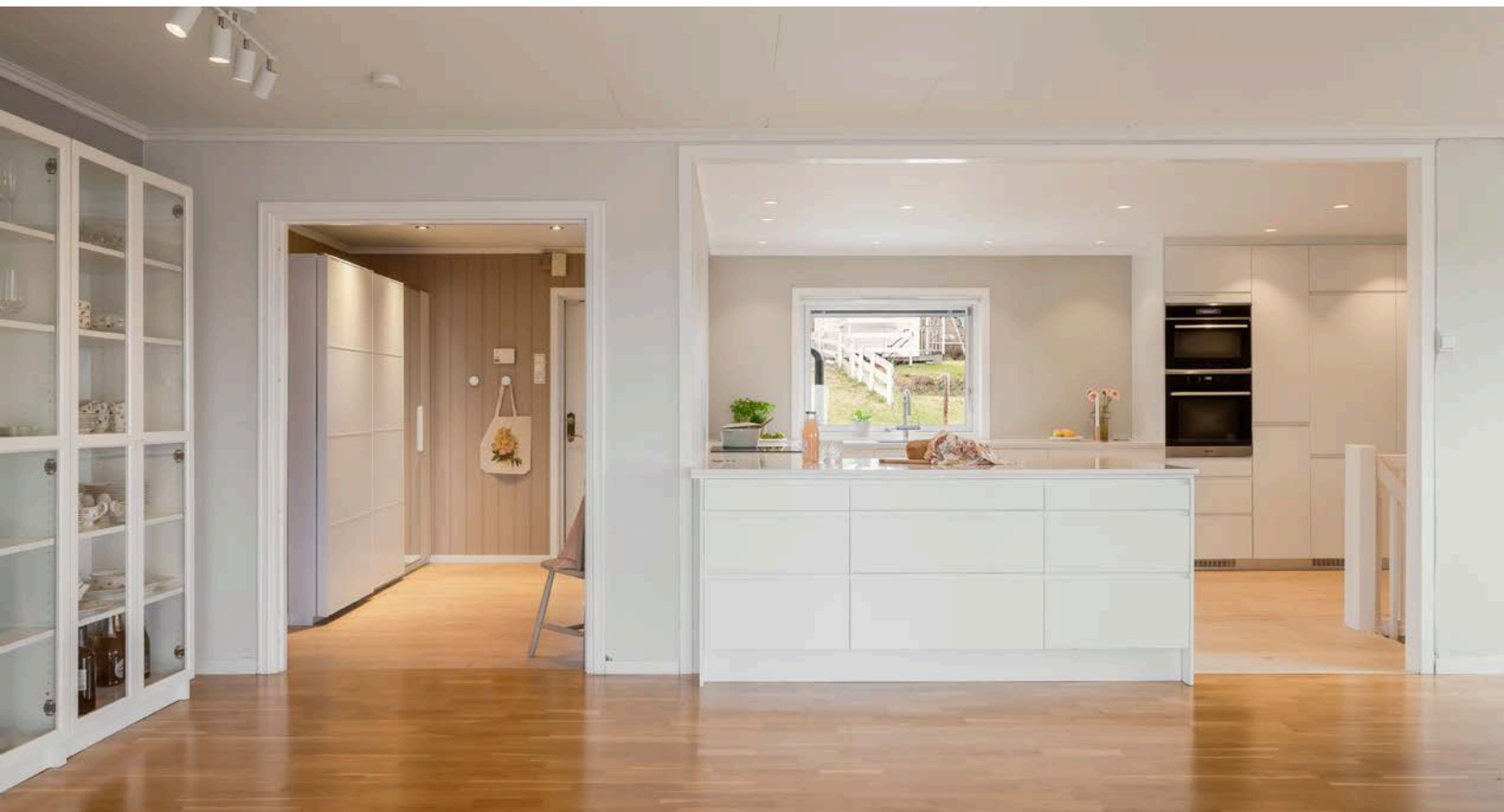
Det ble etablert bergvarme i 2011 som gir gulvvarme til hele 1. etasje med unntak av ett soverom og bad.
