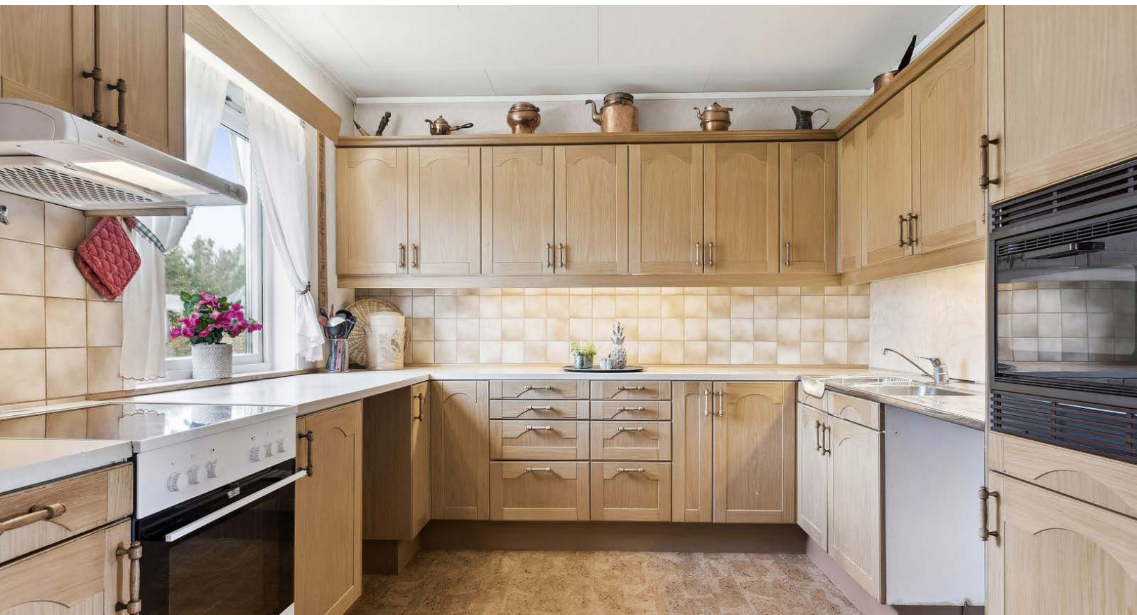
Kjøkkeninnredning fra 1987 av type Drømmekjøkkenet. God skap- og benkeplass i innredningen om har profilerte fronter, laminert benkeplate og benkebeslag med nedfelt oppvaskkum.
