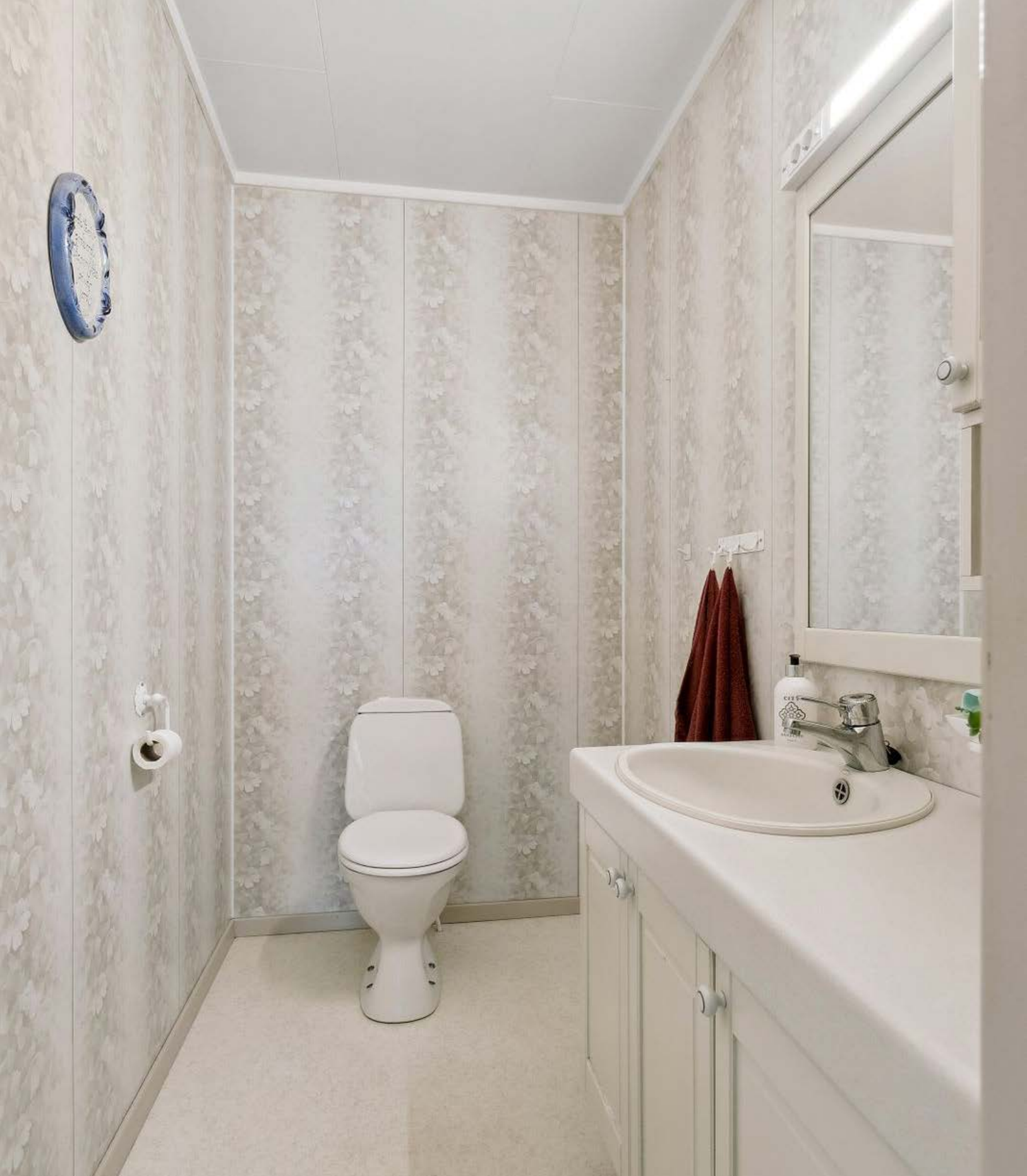
Toalettrom fra 1987 i 1. etasje med belegg på gulv, våtromsplater på veggene og mekanisk avtrekk. Rommet er utstyrt med innredning med servant, speil med belysning over, gulvstående toalett og elektrisk stråleovn.
