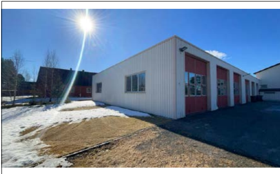
Bilde av garasjen. Påregnelig med generelt vedlikehold.
