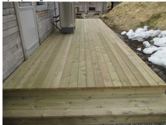
Platting på baksiden av boligen.
