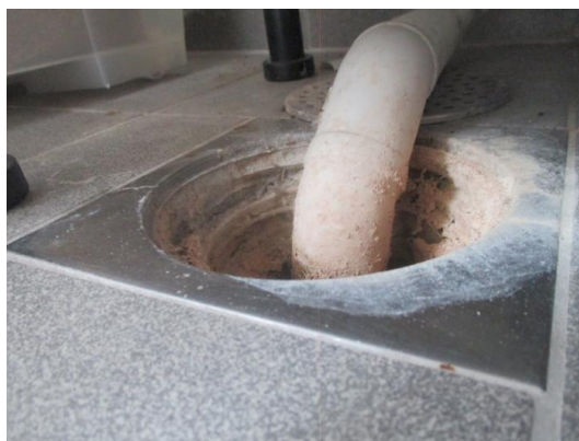
Sluk under innredningen.
