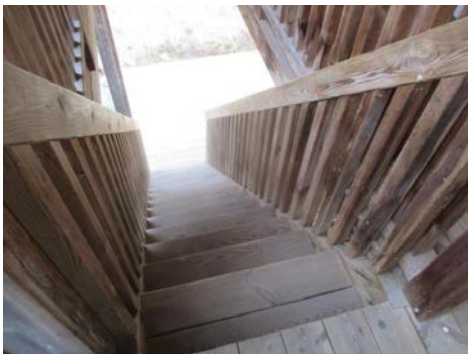
Trapp til veranda over inngangsparti.
