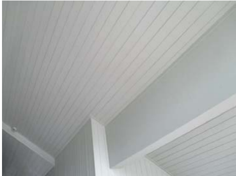
Lukket takkonstruksjon.
