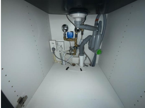
Besiktigelse av røropplegg.
