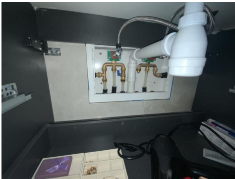
Besiktigelse av røropplegg.
