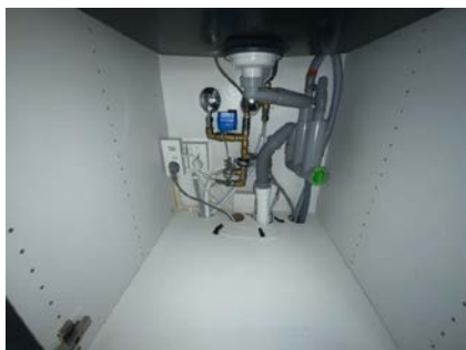
Besiktigelse av røropplegg.
