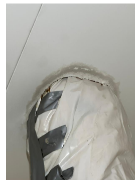
Kondensmerker rundt ventilasjonskanal
