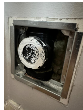
Stakemuligheter på avløpsanlegg, bad plan 1.
