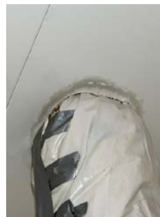
Kondensmerker rundt ventilasjonskanal
