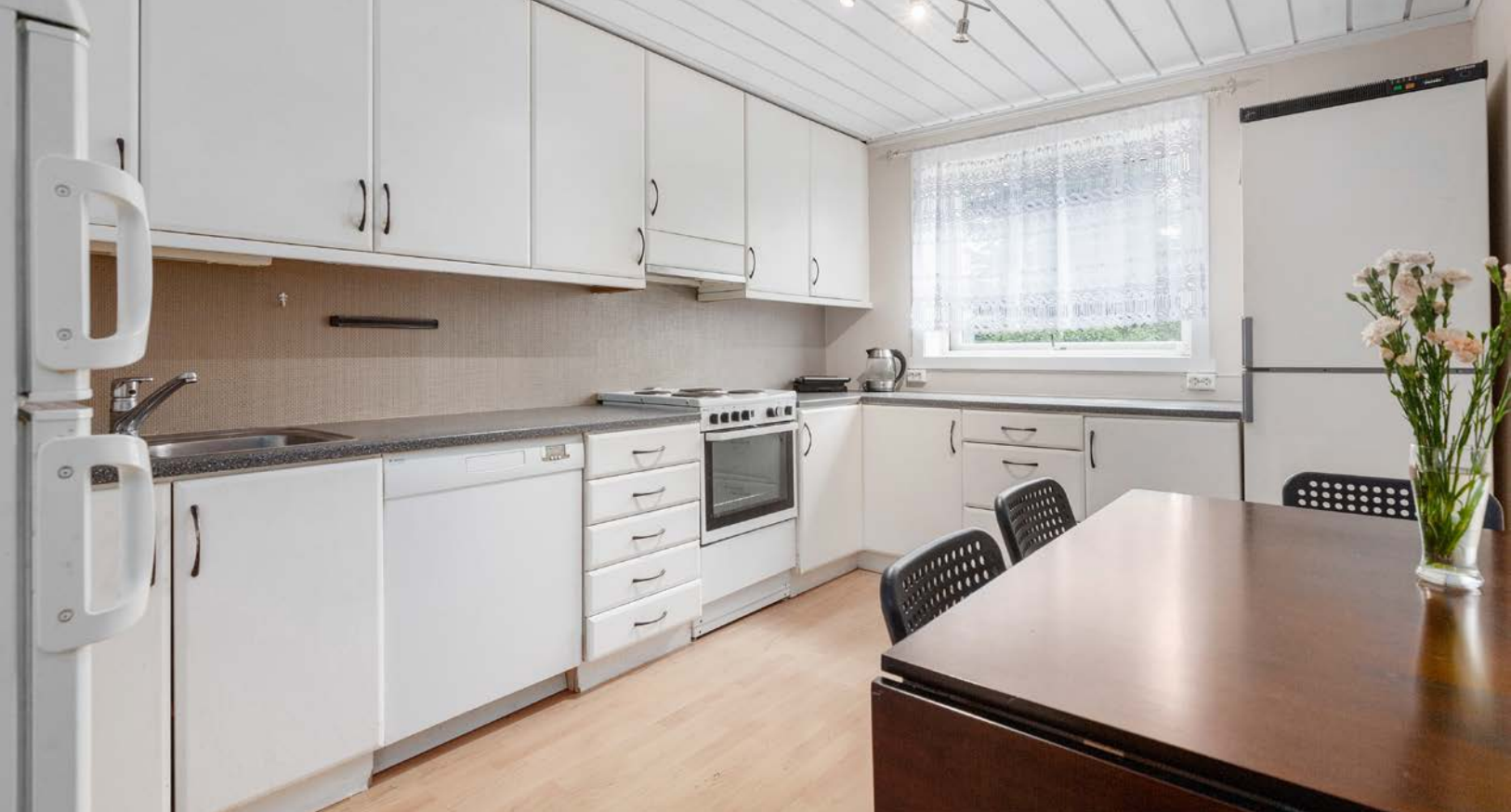
Sokkeletasje. Kjøkkeninnredning av laminerte skrog med laminerte slette fronter, laminert benkeplate med nedfelt oppvaskkum i stål med ett-greps blandebatteri.
