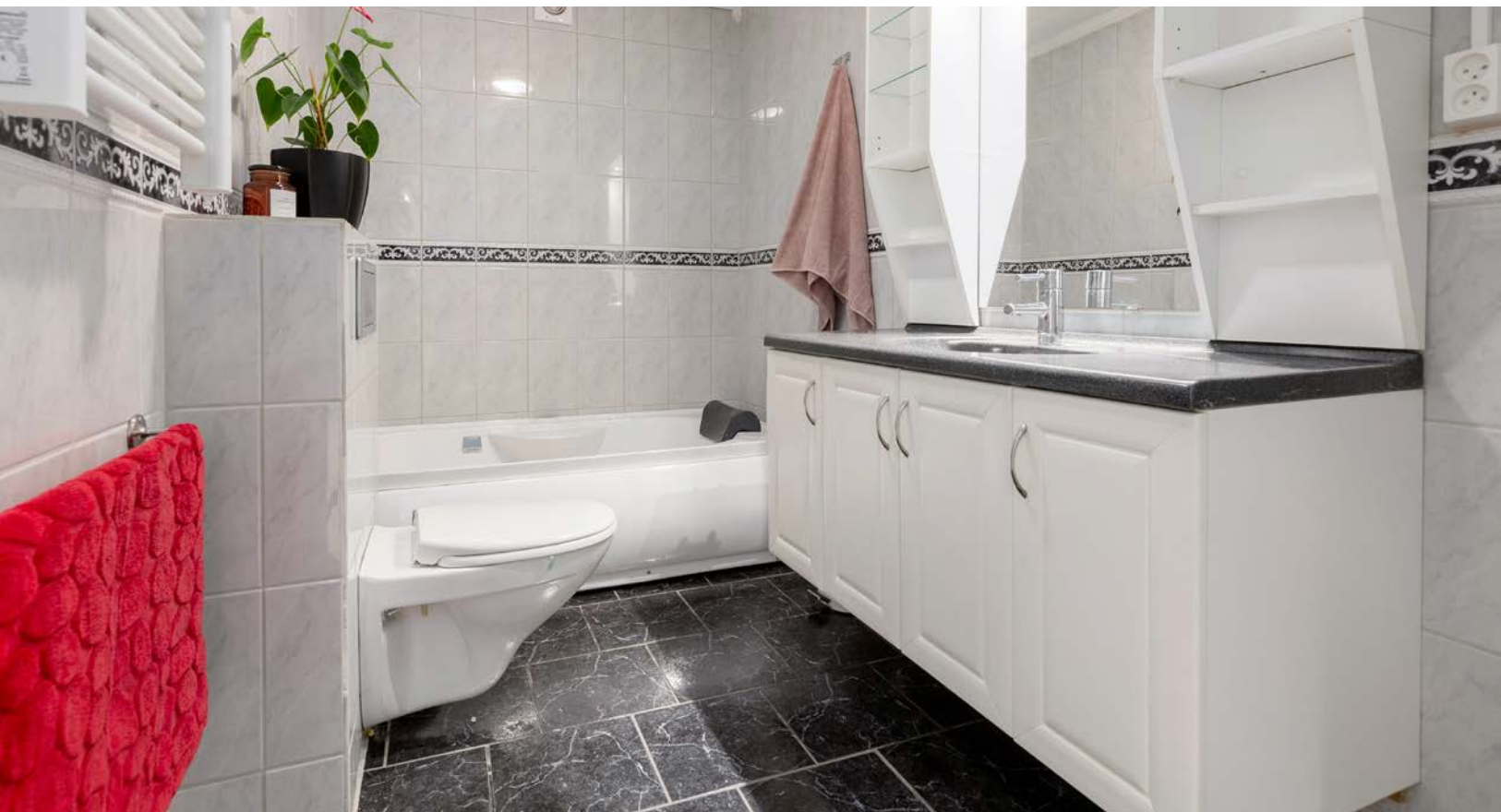
Bad i 1.etg. Gulv er tekket med fliser og har termostatstyrte elektriske varmekabler.
