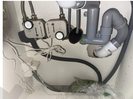
Rørpropp i kjøkkenbenk med Waterguard
