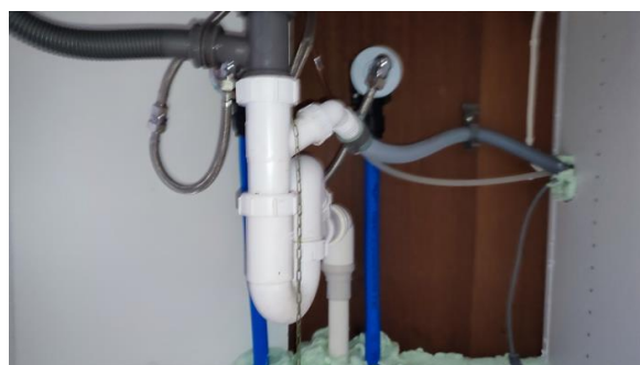
Kontroll av røropplegg.
