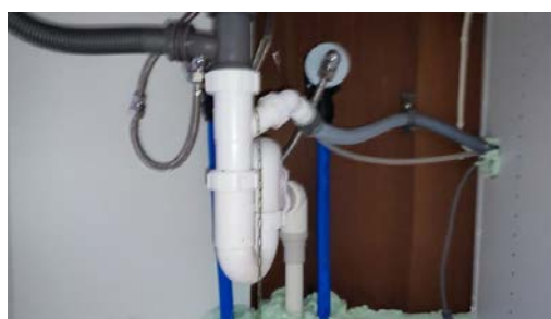
Kontroll av røropplegg.
