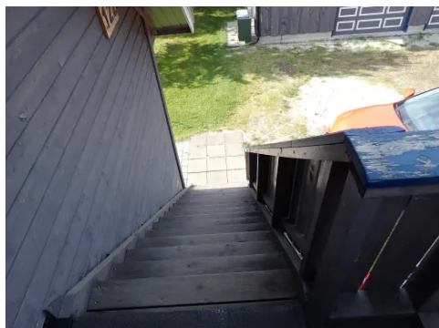
Oversiktsbilde, trapp ved altan.
