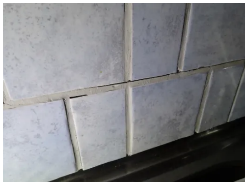
Løsnede fliser.
