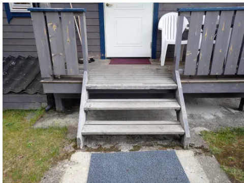
Oversiktsbilde, trapp ved inngangsparti.
