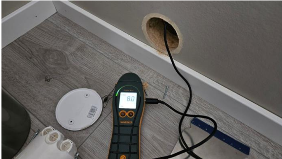
Kontroll av hulltaking.
