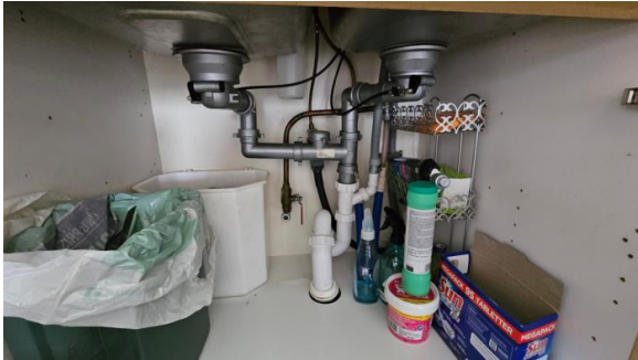
Kontroll av benkeskap.
