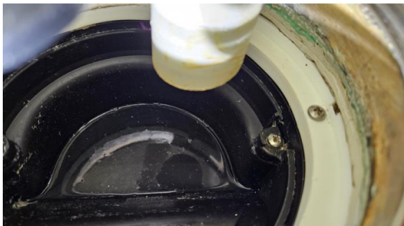
Kontroll av sluk.
