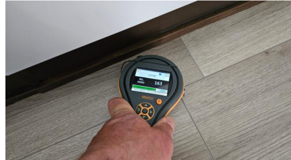
Det ble ved befaring fuktmålt i benkeskap og fremfor oppvaskmaskin, ingen forhøyede verdier ble registrert.
