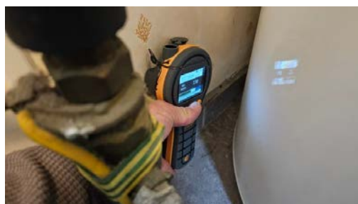
Kontroll av fuktmåling vegg.
