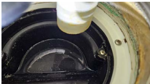
Kontroll av sluk.
