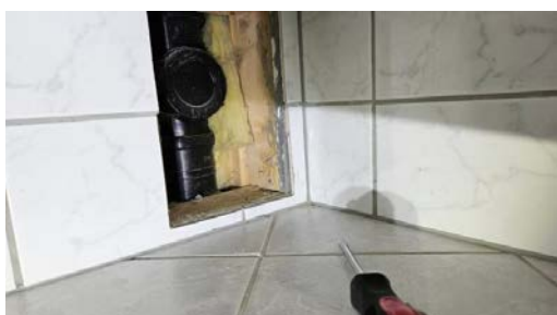
Kontroll av stakepunkt.
