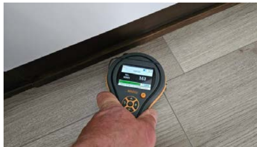
Det ble ved befaring fuktmålt i benkeskap og fremfor oppvaskmaskin, ingen forhøyede verdier ble registrert.
