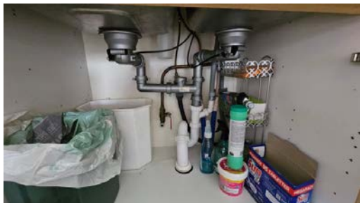
Kontroll av benkeskap.
