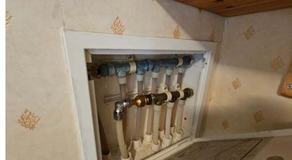
Kontroll av vannskap.
