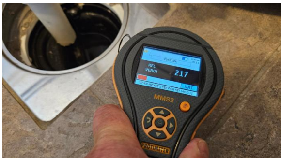
Kontroll av fuktmåling.
