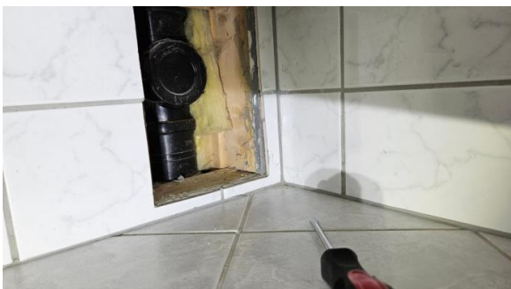
Kontroll av stakepunkt.
