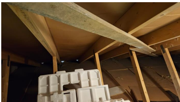
Luftespalter er presset opp mot undertak.
