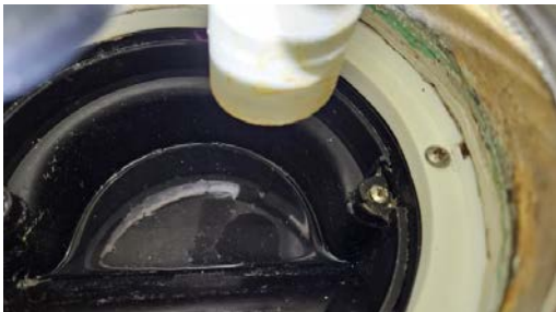
Kontroll av sluk.
