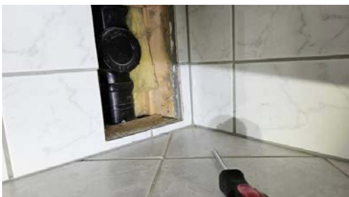
Kontroll av stakepunkt.
