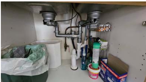
Kontroll av benkeskap.
