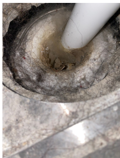
Sluk med synlig smøremembran og klemring.
