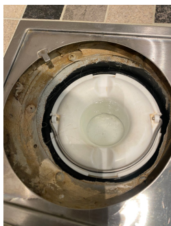
Sluk med synlig smøremembran og klemring.
