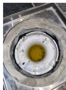
Sluk med synlig smøremembran og klemring.
