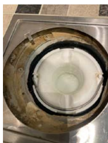
Sluk med synlig smøremembran og klemring.
