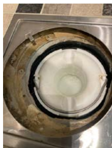
Sluk med synlig smøremembran og klemring.
