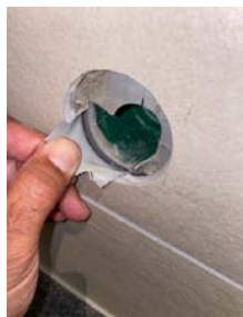
Ufagmessig utførelse membranmansjett.
