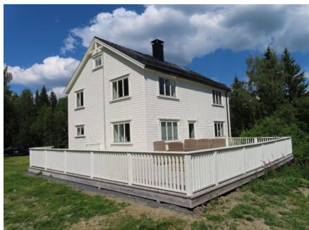
Åpne terrassearealer etter øvre og bakre side av bygget.
