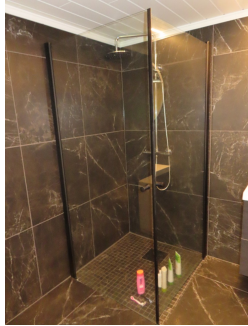
Dusjnise med slagdører i herdet glass som kan legges inn mot vegg når ikke i bruk.
