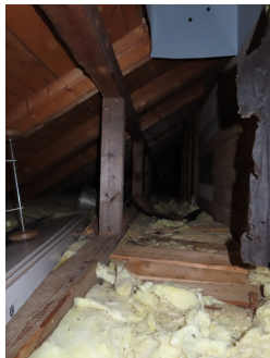
Del av kneloftet sett fra trappegang.
