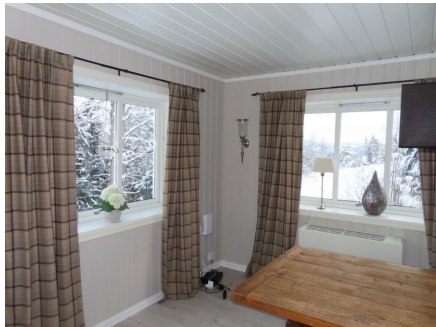
Vinduer med luftespalte i overkarm.
