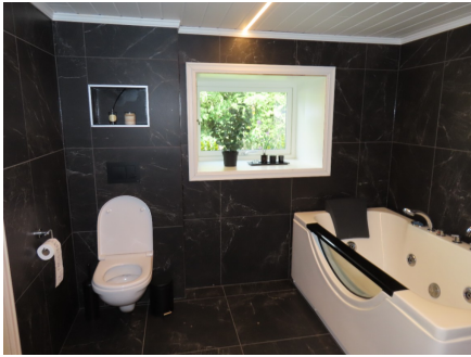
Del av bad i kjellerplanet. Badekar samt veggghent toalett med innebygd systerne.
