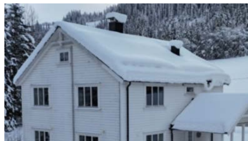
Det er etablert en luftehett inn på kneloftet for å imøtekomme og prøve å få tilstrekkelig utlufting av dette for å unngå kondensering.
