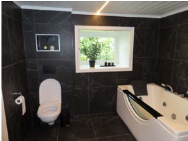
Del av bad i kjellerplanet. Badekar samt veggheint toalett med innebygd sistene.
