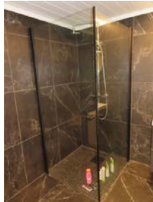
Dusjnise med slagdører i herdet glass som kan legges inn mot vegg når ikke i bruk.
