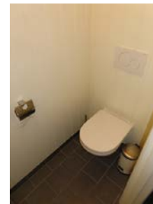
Del av toalettrom. Toalett med innebygd sisterne.
