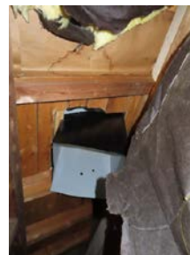
Det er etablert en luftehett inn på kneloftet for å imøtekomme og prøve å få tilstrekkelig utlufting av dette for å unngå kondensering.
