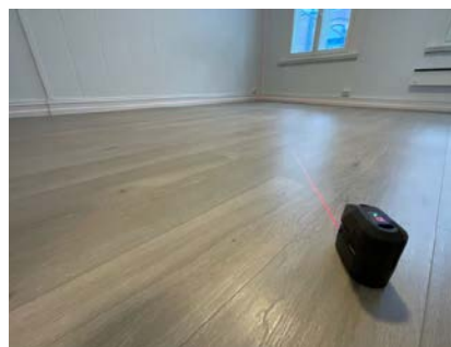
Nivellering stue, ingen avvik registrert
