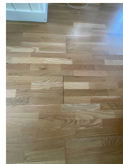
Glippe i endeskjøt i laminatgulv
