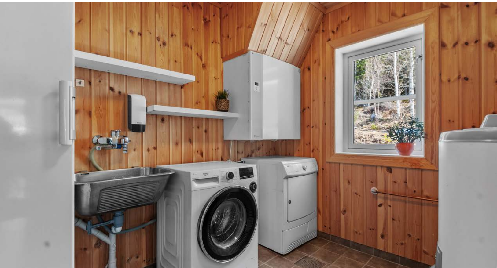
Vaskerommet som også huser mye av boligens tekniske utstyr ligger i tilknytning til entréen
