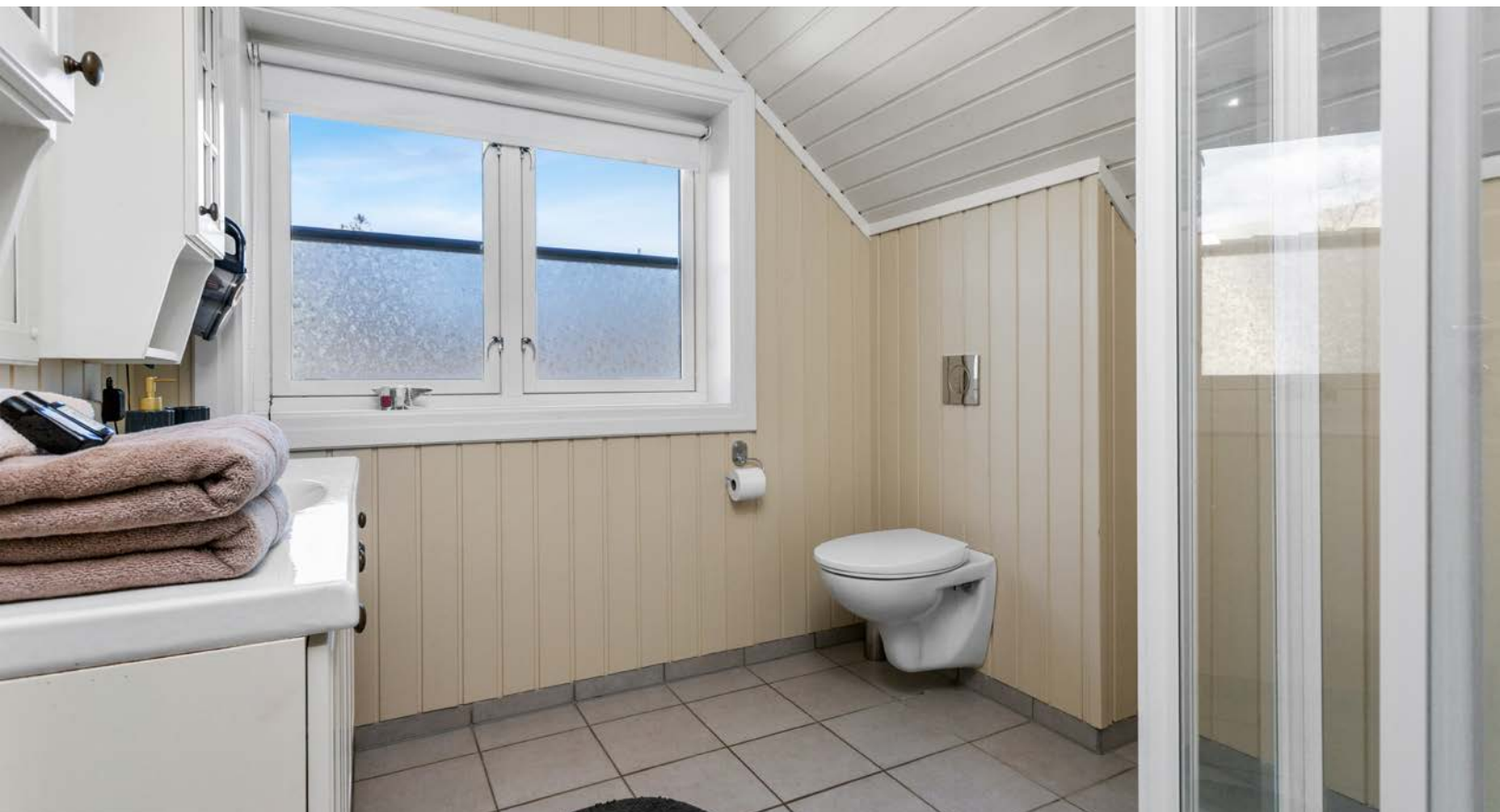
Badet i 2. etasje har flislagt gulv med undervarme, malte panelvegger og malt panelhimling
