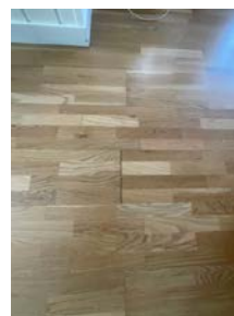
Glippe i endeskjøt i laminatgulv
