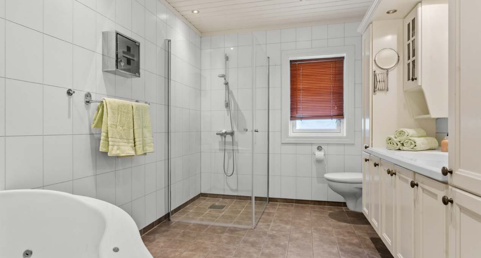
Badet i 1. etasje har flislagt gulv med undervarme, våtromsplater på vegger og malt panelhimling med downlights
