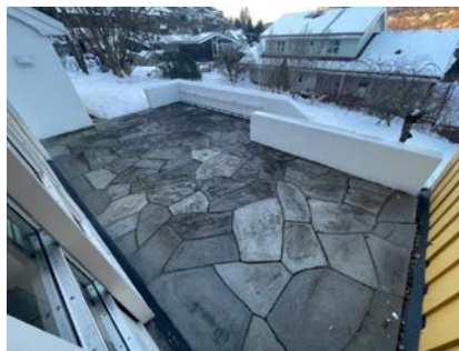
Lav t rekkverk terrasse
