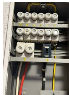
Sikringsskap med automatsikringer.
