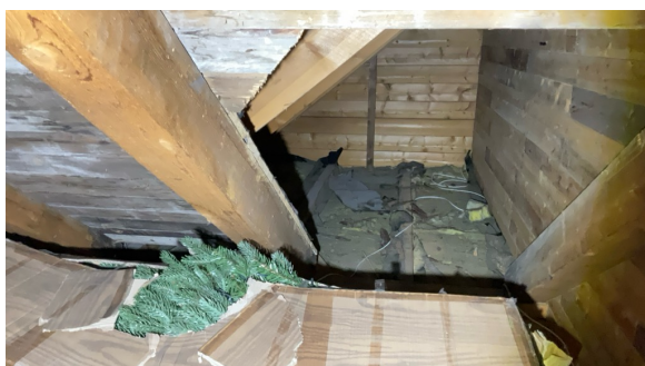
Det er begrenset tilgang til konstruksjonen.
