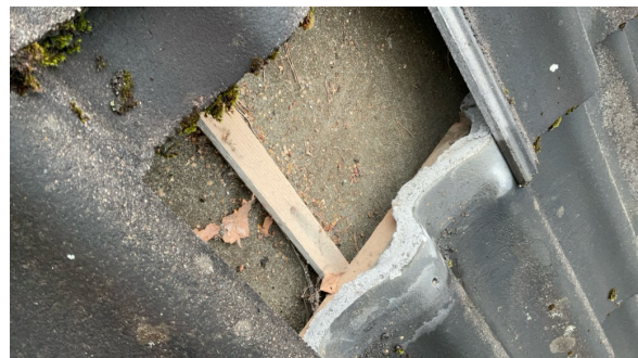
Undertak med takpapp.
