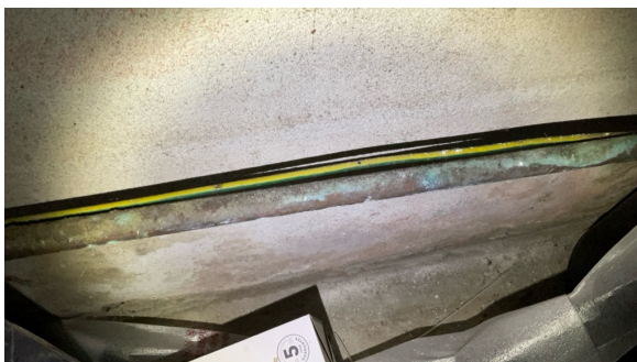
Vannrør med irr.
