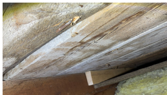
Synlig luftespalte mellom undertak og isolasjon
