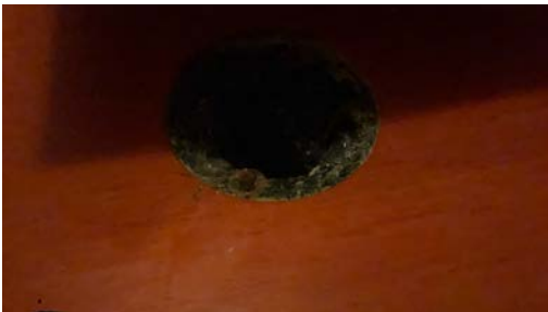
Sluk i gulv.
