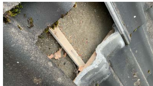
Undertak med takpapp.
