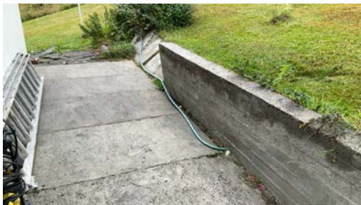
Jordkabel er nesten frem til yttervegg.
