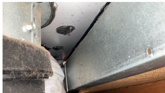
Det er synlig lysåpning/utettheter i beslag ved gjennomføring i takflaten.
