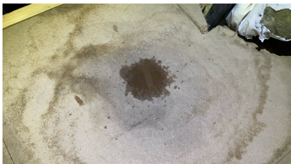
Vanndråper synlig under luftehatt/gjennomføring i tak
