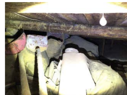
Deler av krypkjeller.
