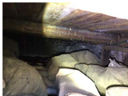
Deler av krypkjeller.
