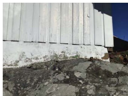
Del av grunnmur.
