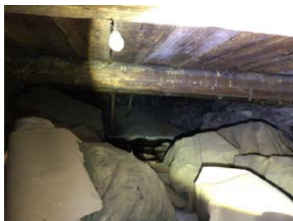
Etasjeskille sett fra krypkjeller.
