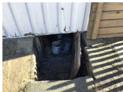
Luke inn til krypkjeller.
