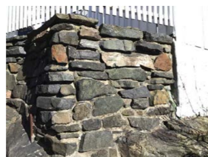
Del av forstøtningsmur.
