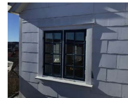
Eksempel på vindu i yttervegg.
