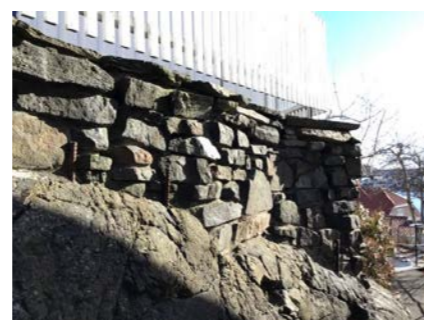
Del av forstøtningsmur.
