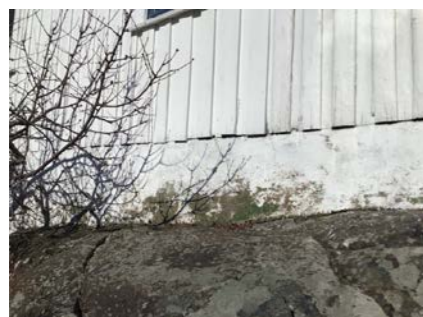
Del av grunnmur.
