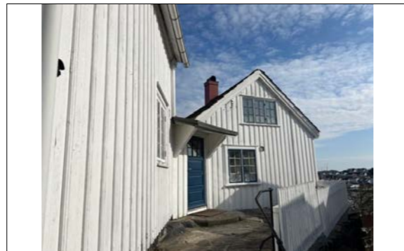
Bilde tatt på befaringdagen 12-3-2024
