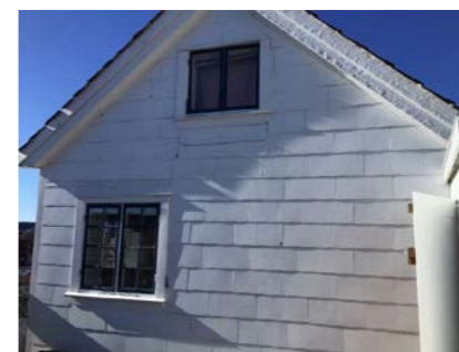
Vegg med eternitt plater.
