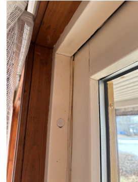
Ekstra pakning på balkongdør mot øst.
