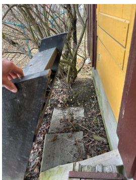
Løs trapp ved bod til garasje, samt ingen rekkverk.
