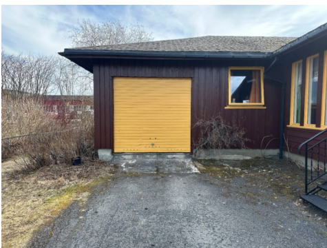
Synkeproper i asfalt
