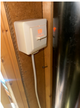
Tilkobling til varmtvannsbereder.
