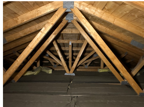
Takkonstruksjon av w-takstoler.
