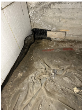
Innvendig i krypkjeller mot innredd kjeller rom er det stedvis synlig vorteplast.
