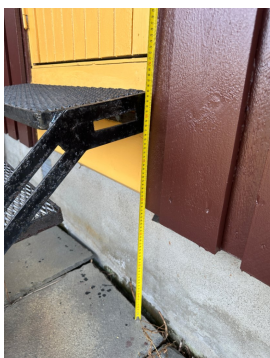
Løs trapp ved bod til garasje, samt ingen rekkverk.
