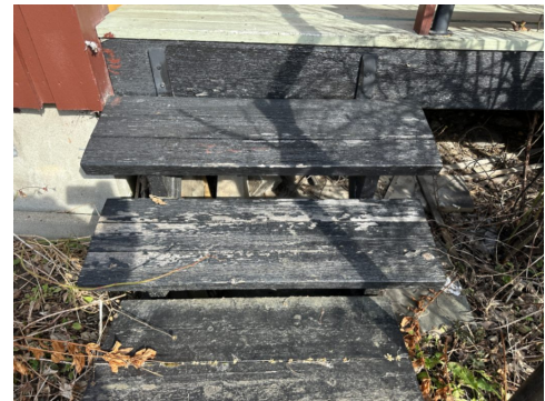
Råteskadet trapp.
