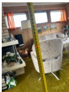
Målt avvik. gjennom rommet: 6mm
