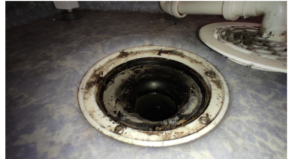
Kontroll av sluk.
