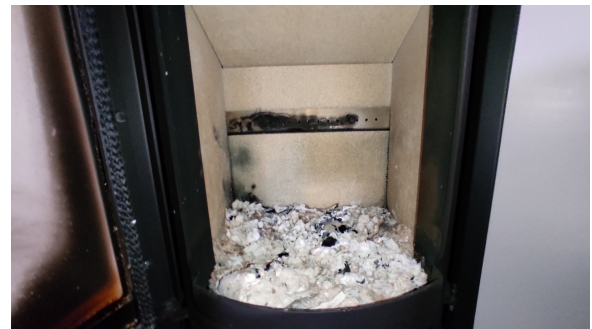
Kontroll av ildstedet.
